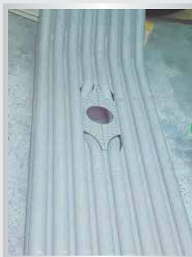
吹灰口管排 (Gas pipe)
