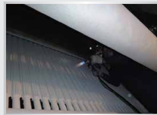
ORV Panel 鰭管熔射工程 (Công trình phun phủ ống tản nhiệt ORV)
