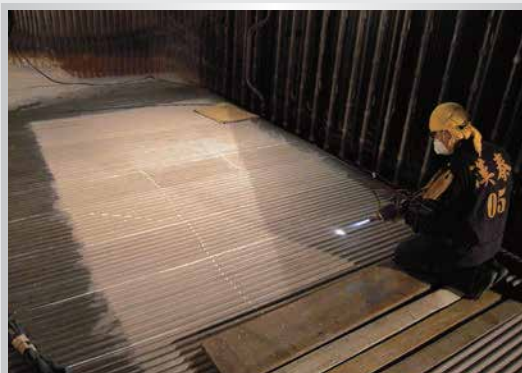
爐管施工 (Thi công ống lò hơi)
