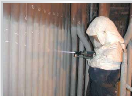
鍋爐水管牆熔射 (Phun phủ trên ống nước lò hơi)
